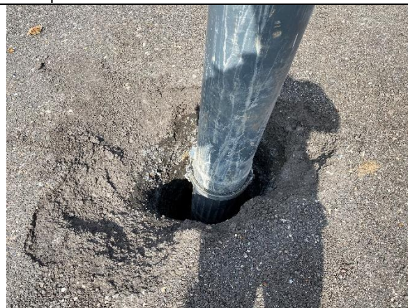
Mise en aspiration des argiles
