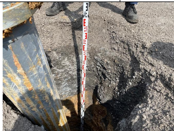
Fond de fouille à 4 mètres de profondeur
