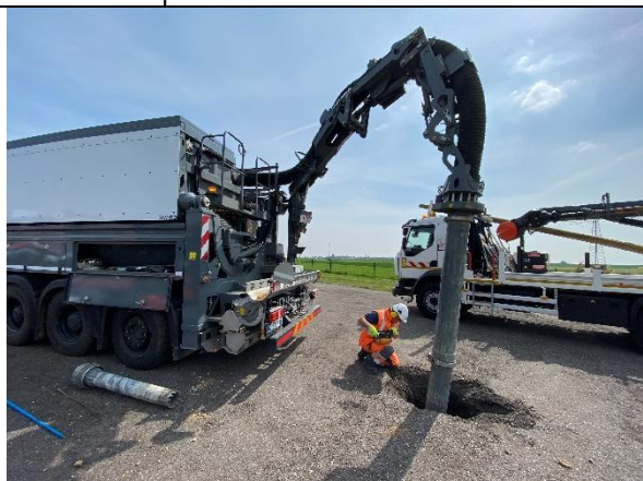
Aspiratrice Excavatrice en action
